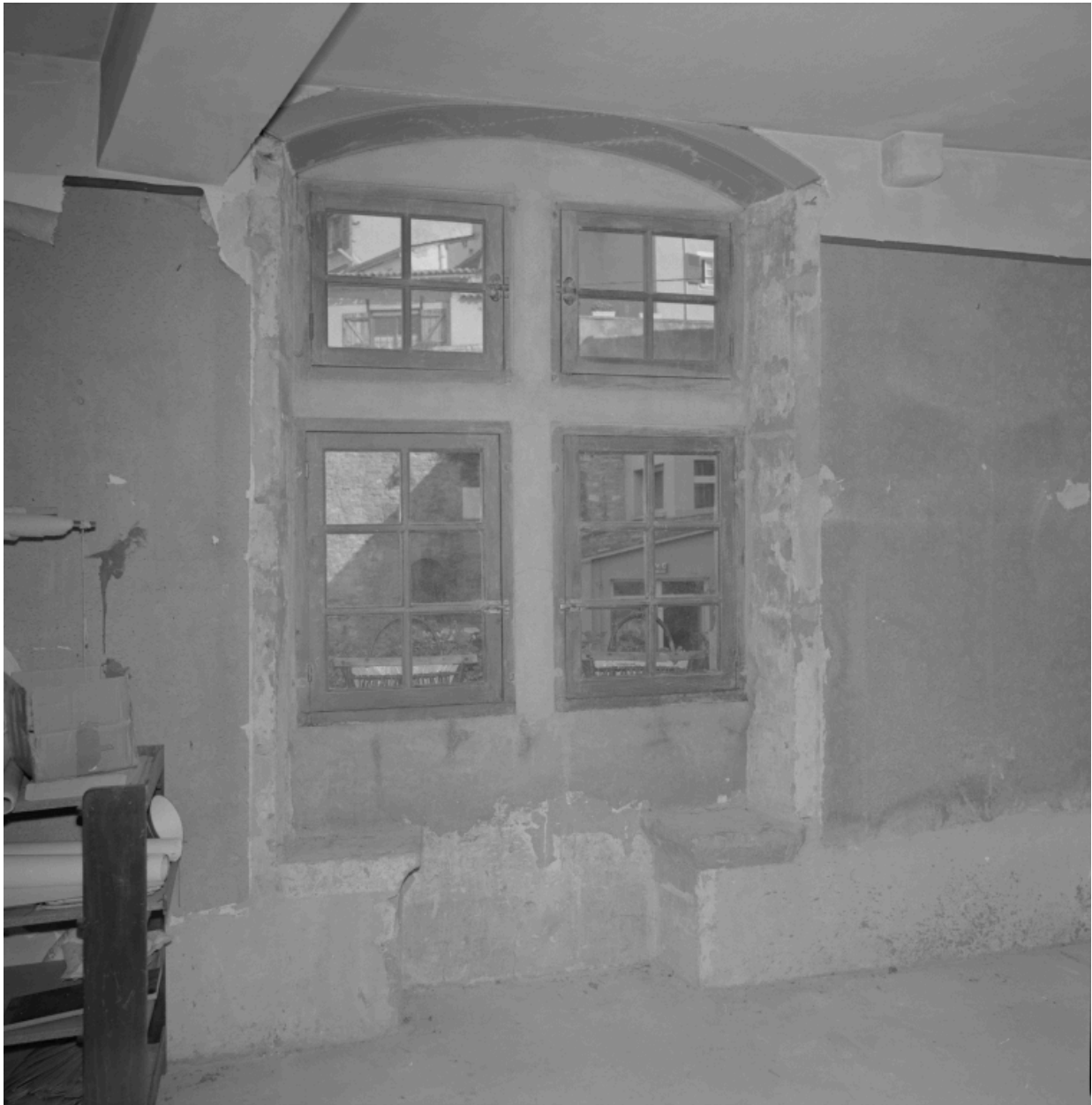
Fenêtre à coussièges, au 1er. étage.
