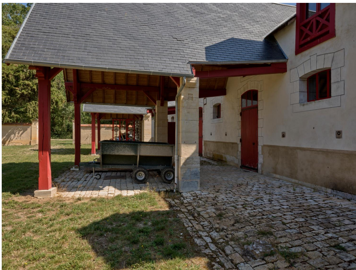
Façade occidentale des écuries.
