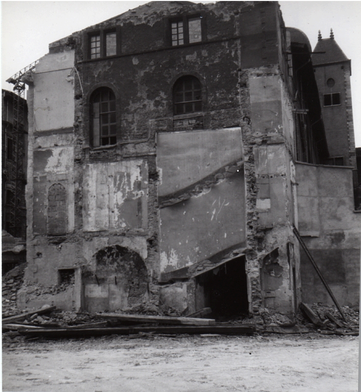
Démolition du passage, l'espace libéré au niveau du bâtiment O
