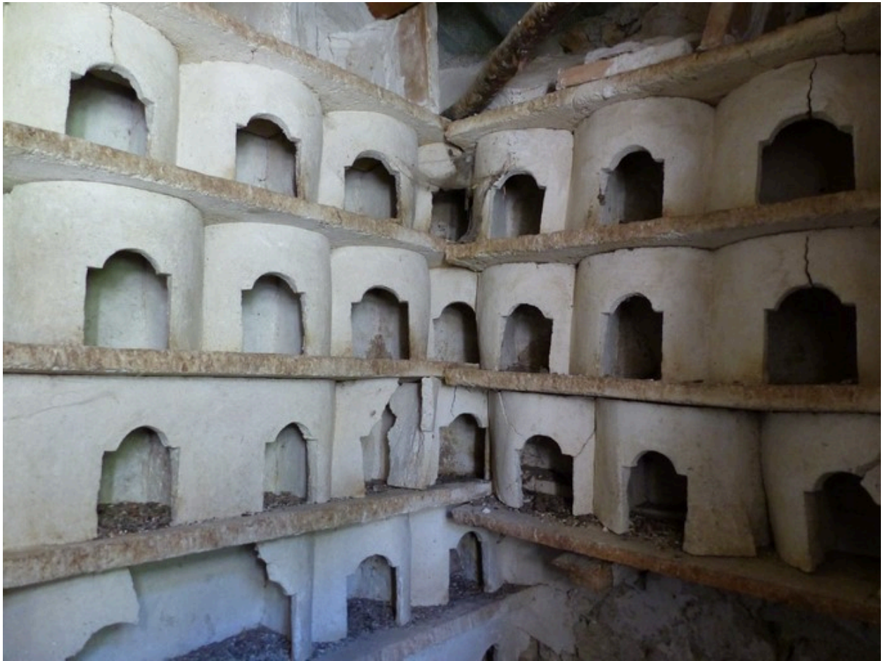
Etage de comble. Angle nord-est, boulins.
