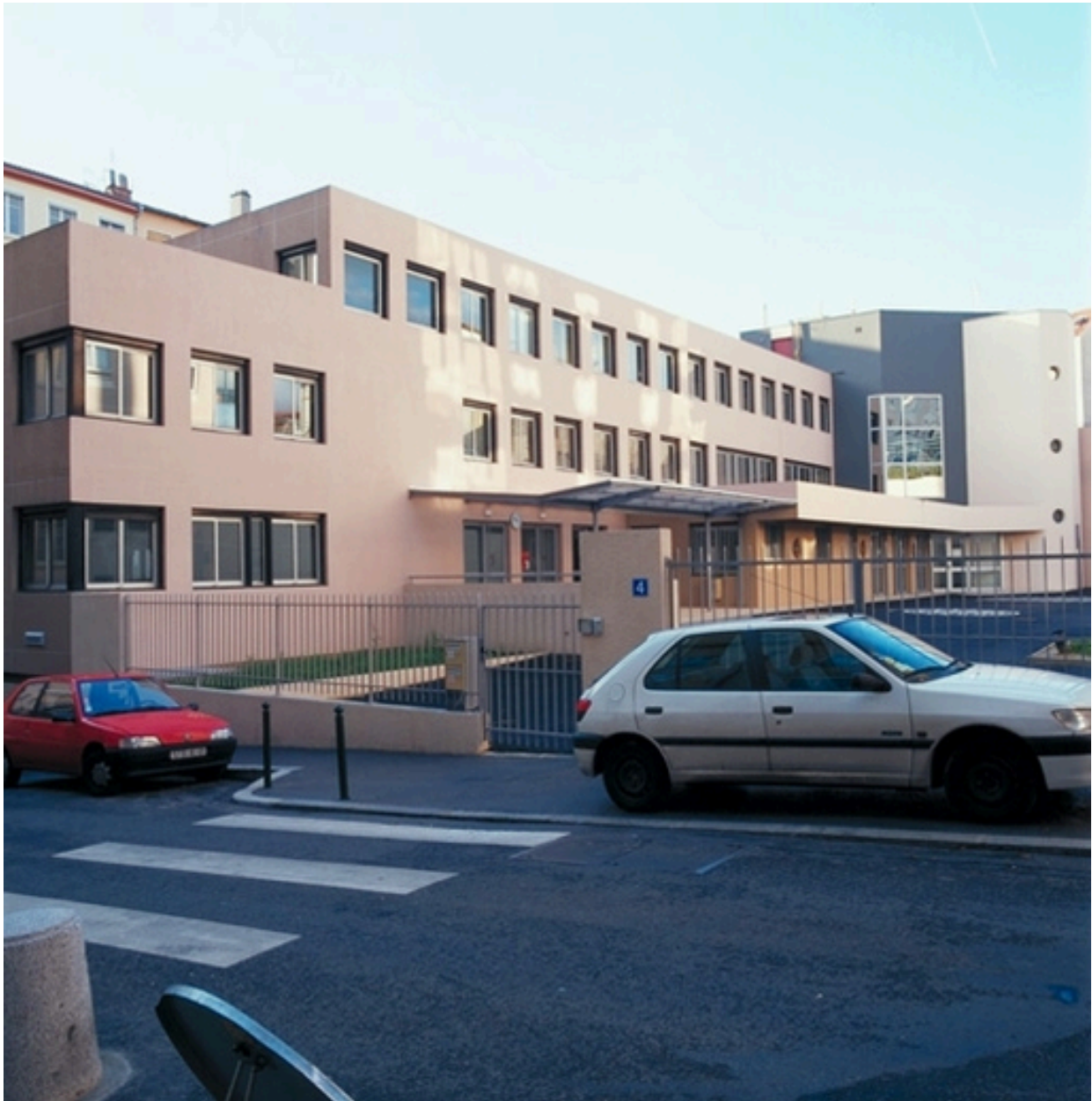
Vue du bâtiment réutilisé
