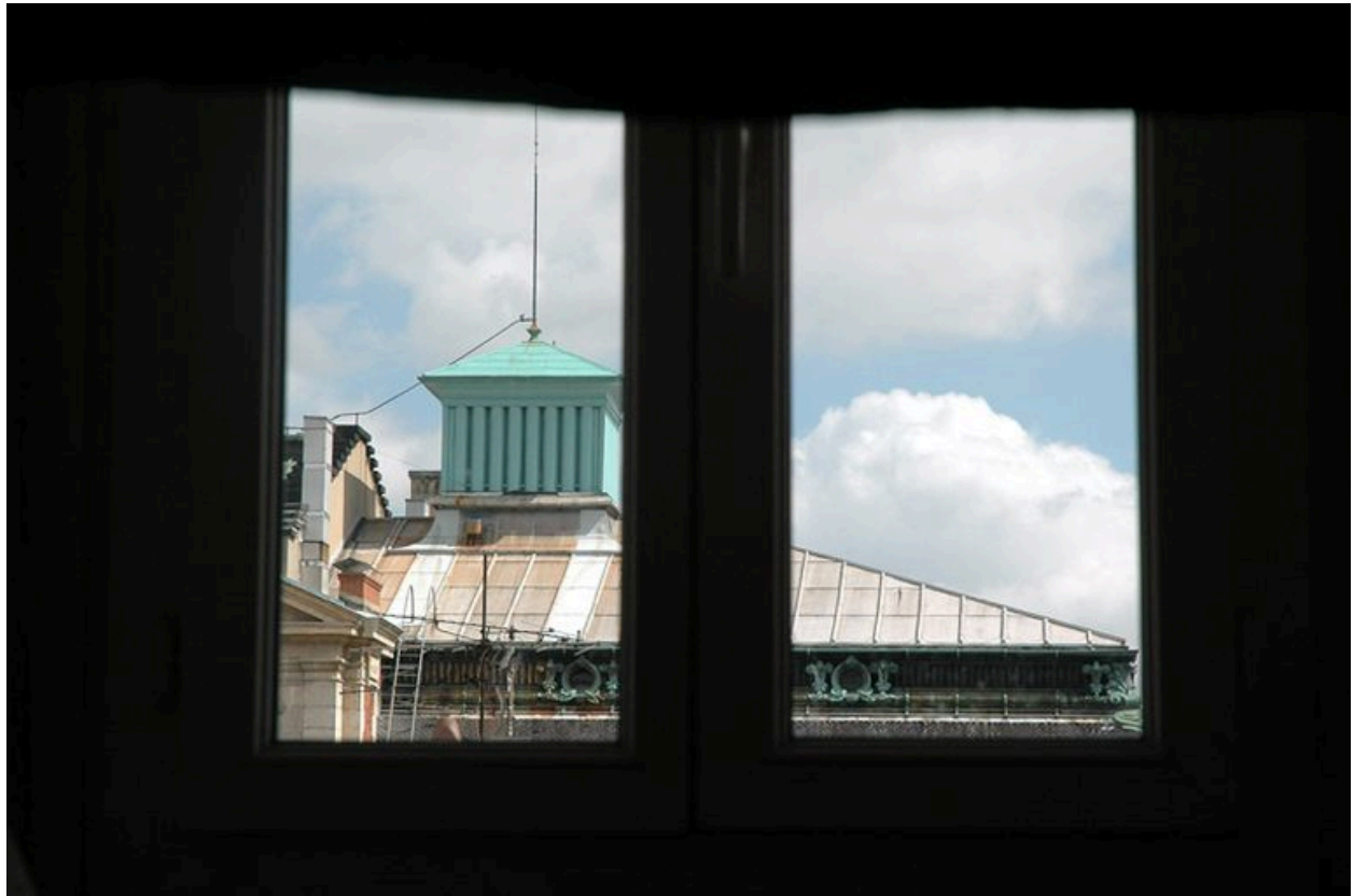
Vue partielle de la toiture depuis la cage d'escalier de l'immeuble sis 4 rue des Templiers
