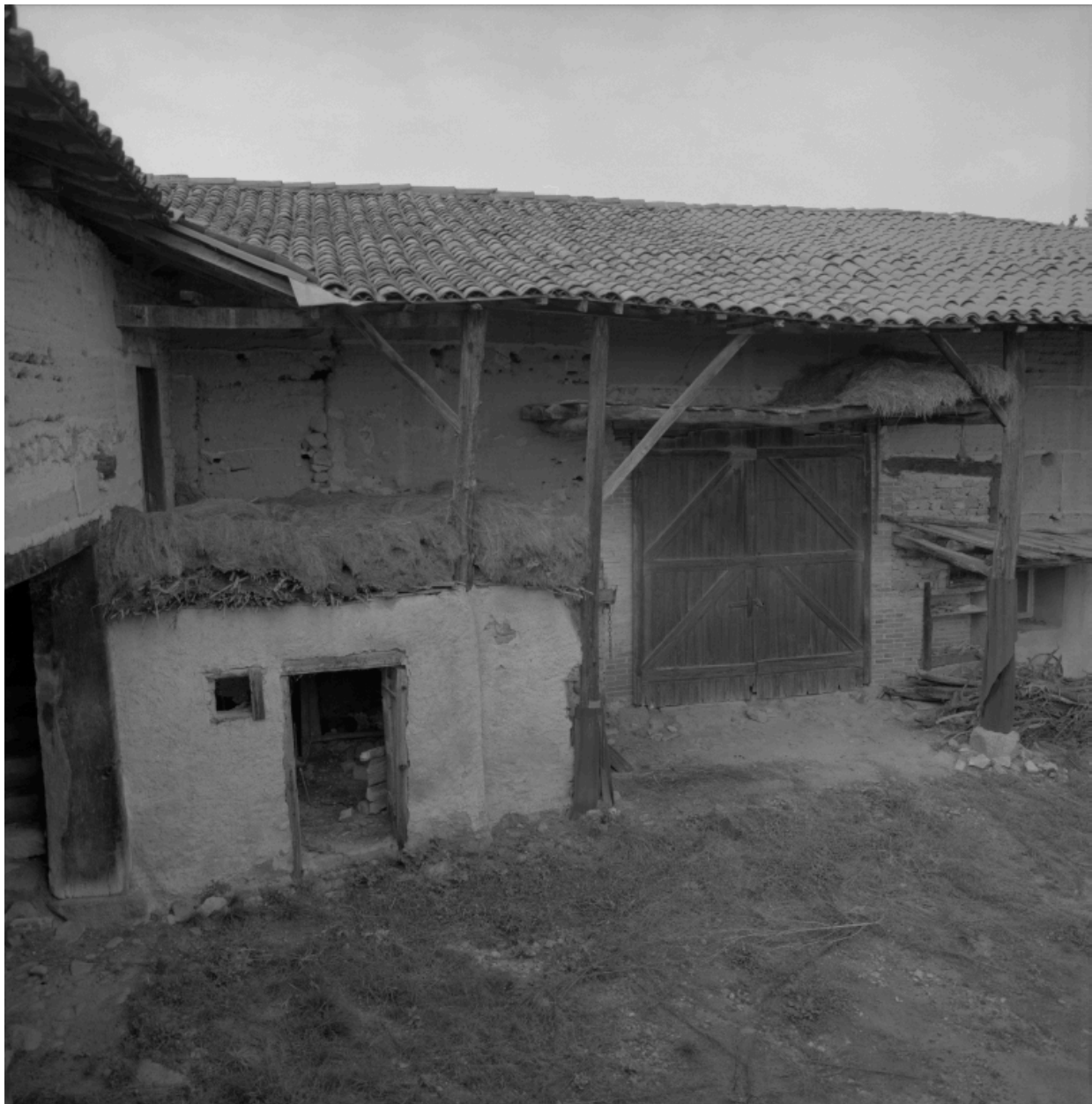
Bussy-Albieux, Albieux (1987 A2 866), type A1. Ferme à galerie, vue intérieure de la cour, porcherie au-devant de la grange-étable.
