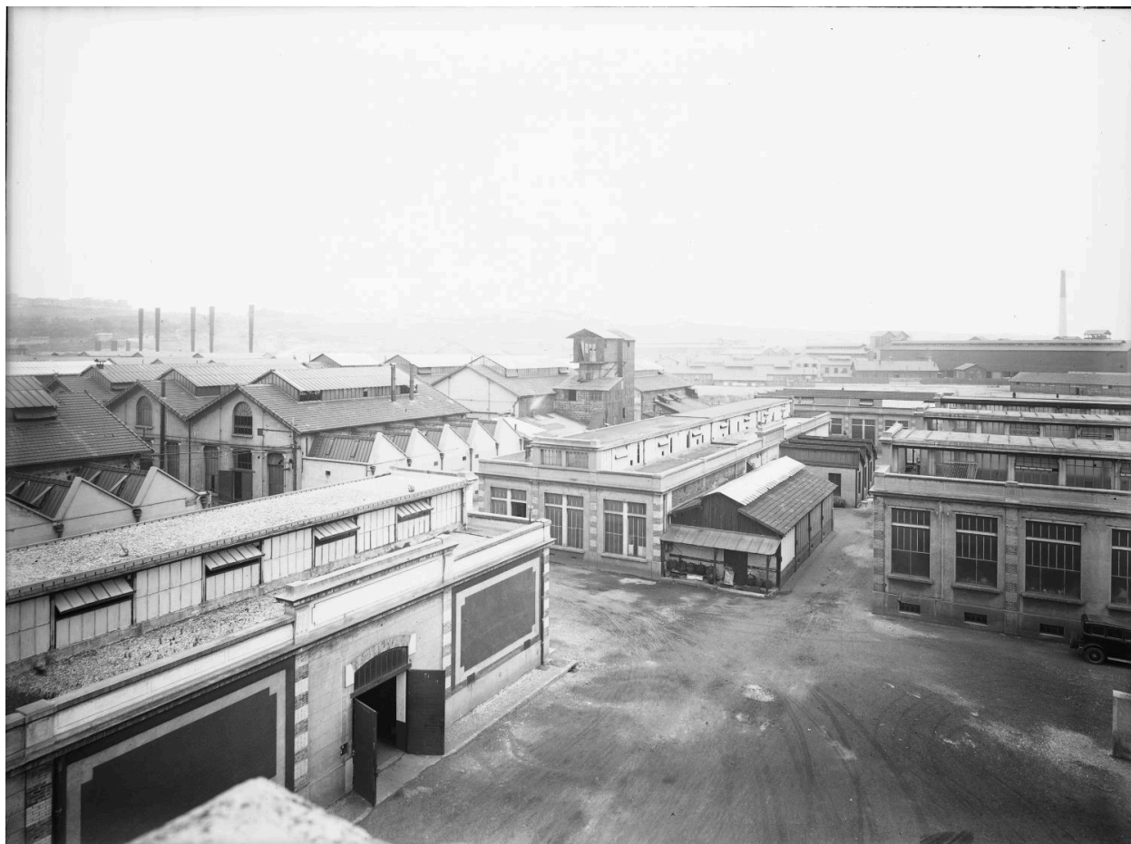
Vue d'architecture Rhône-Poulenc usine 1910 (BML : P0546 S 1691)
