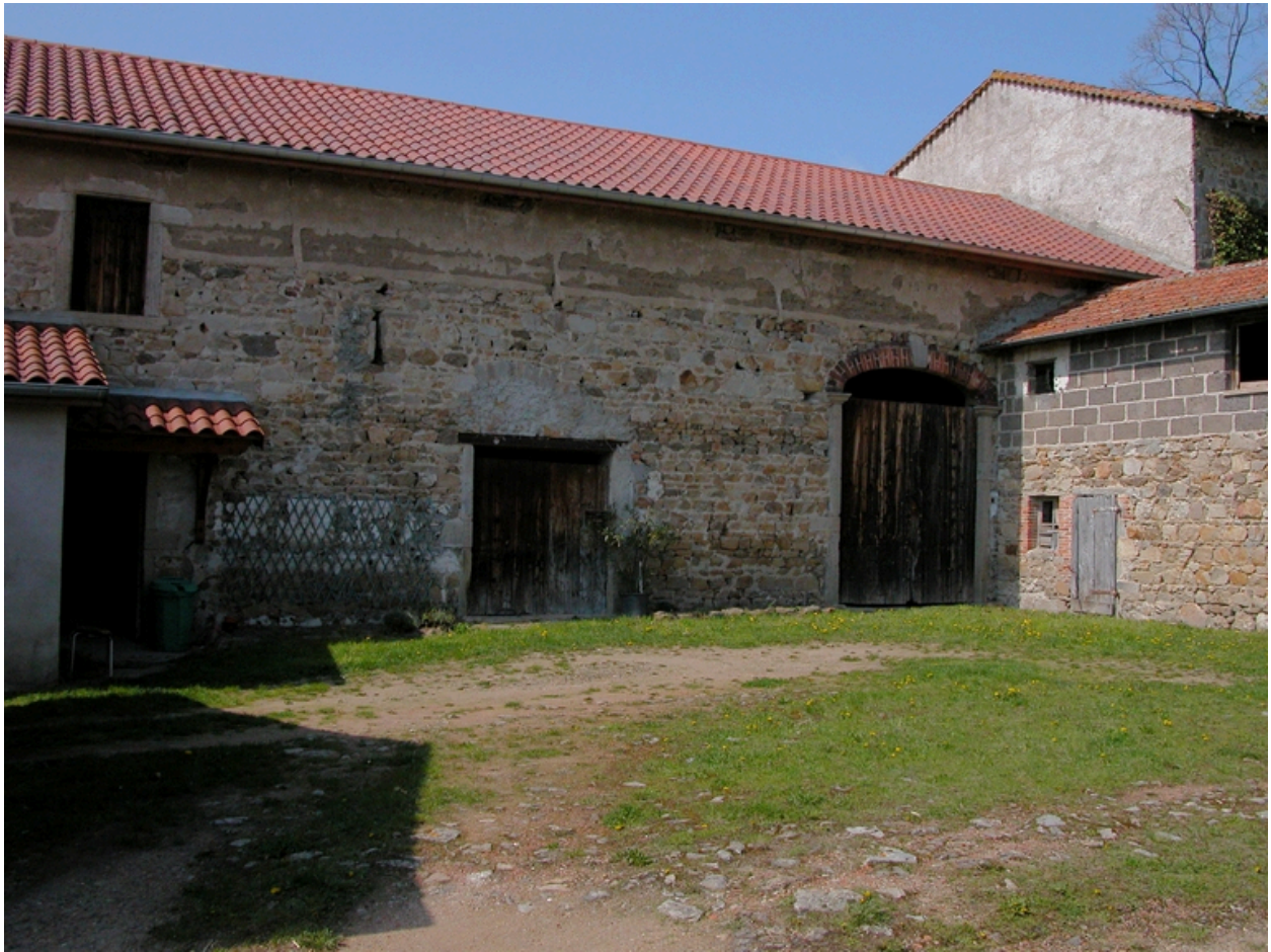
Vue d'ensemble de l'étable, remise et grange, depuis l'intérieur de la cour.
