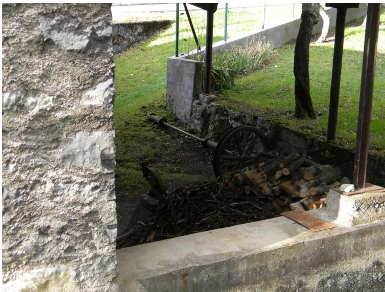
Détail d'un arbre moteur devant le bâtiment.
