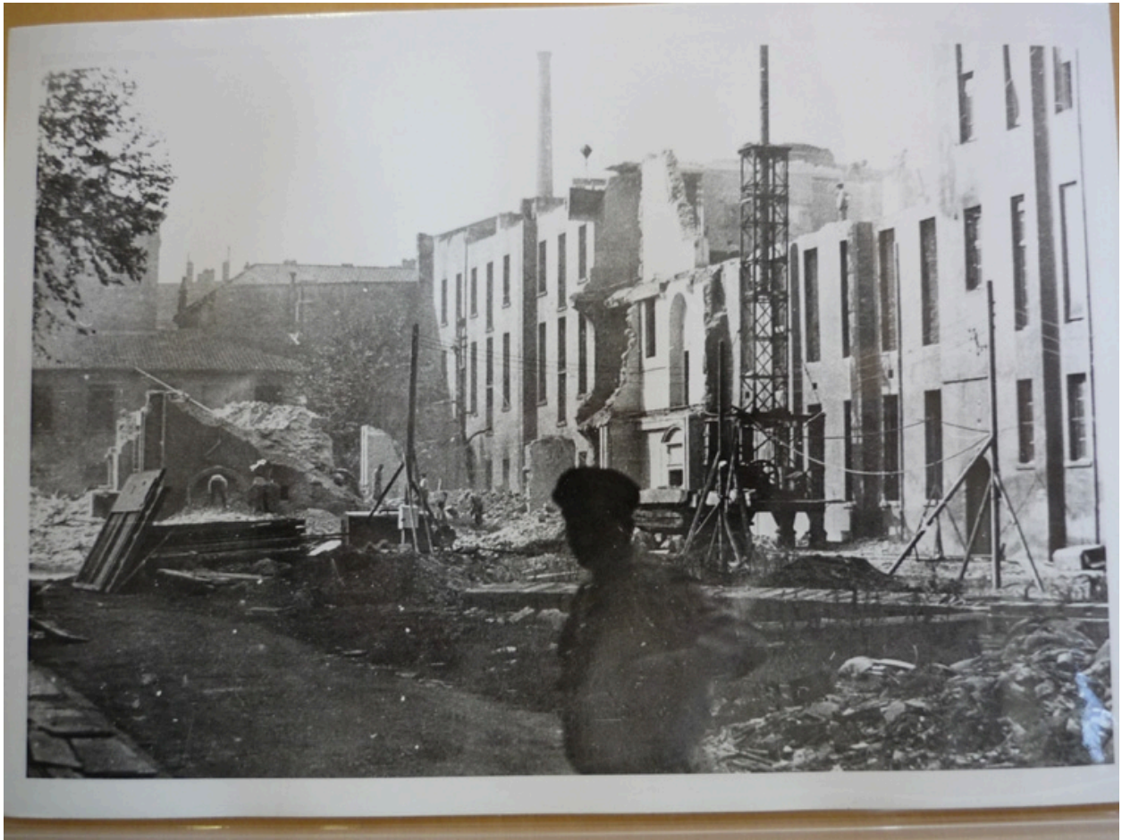
Vue d'ensemble, démolition, 1934. Photographie AC Lyon. 2PH31
