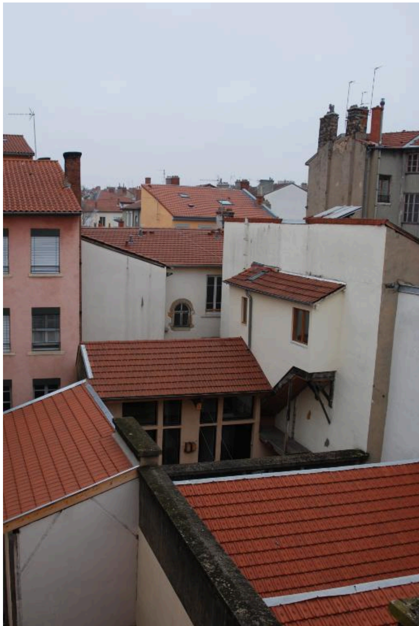
Vue partielle des bâtiments en coeur d'îlot, depuis le sud
