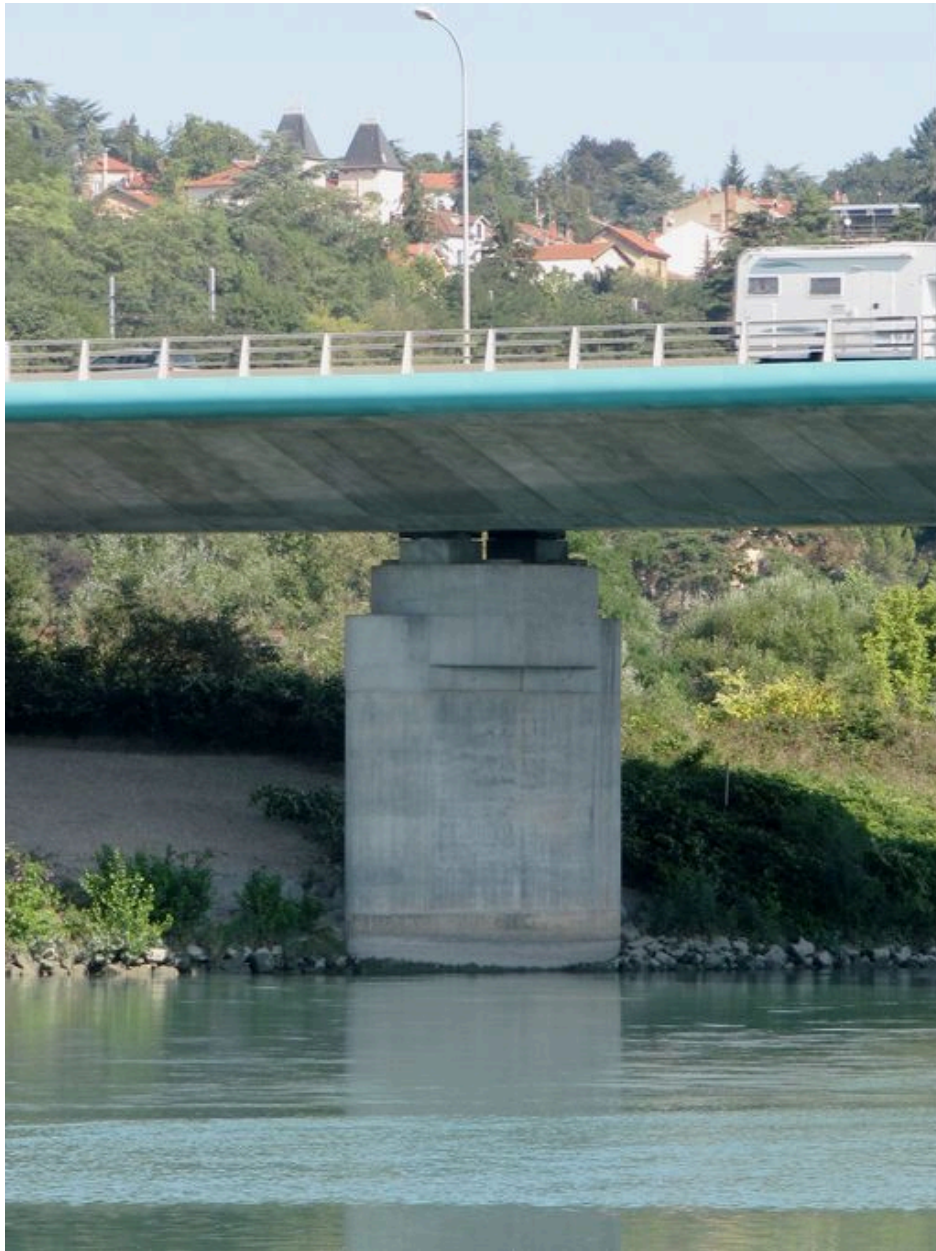
Pile, face aval, vue générale (depuis la rive gauche)
