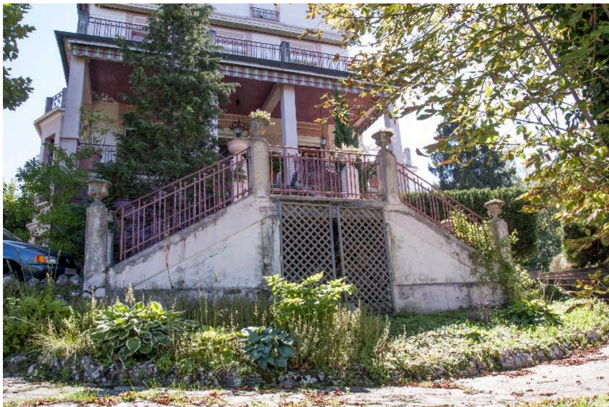
Escalier double reliant la terrasse et le jardin, façade ouest
