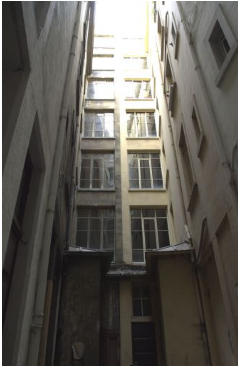
Vue des montées d'escalier parallèles depuis la cour
