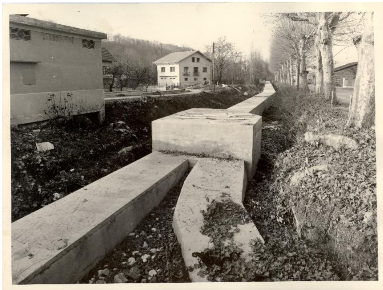
Travaux de canalisation du Tillet, vers 1965
