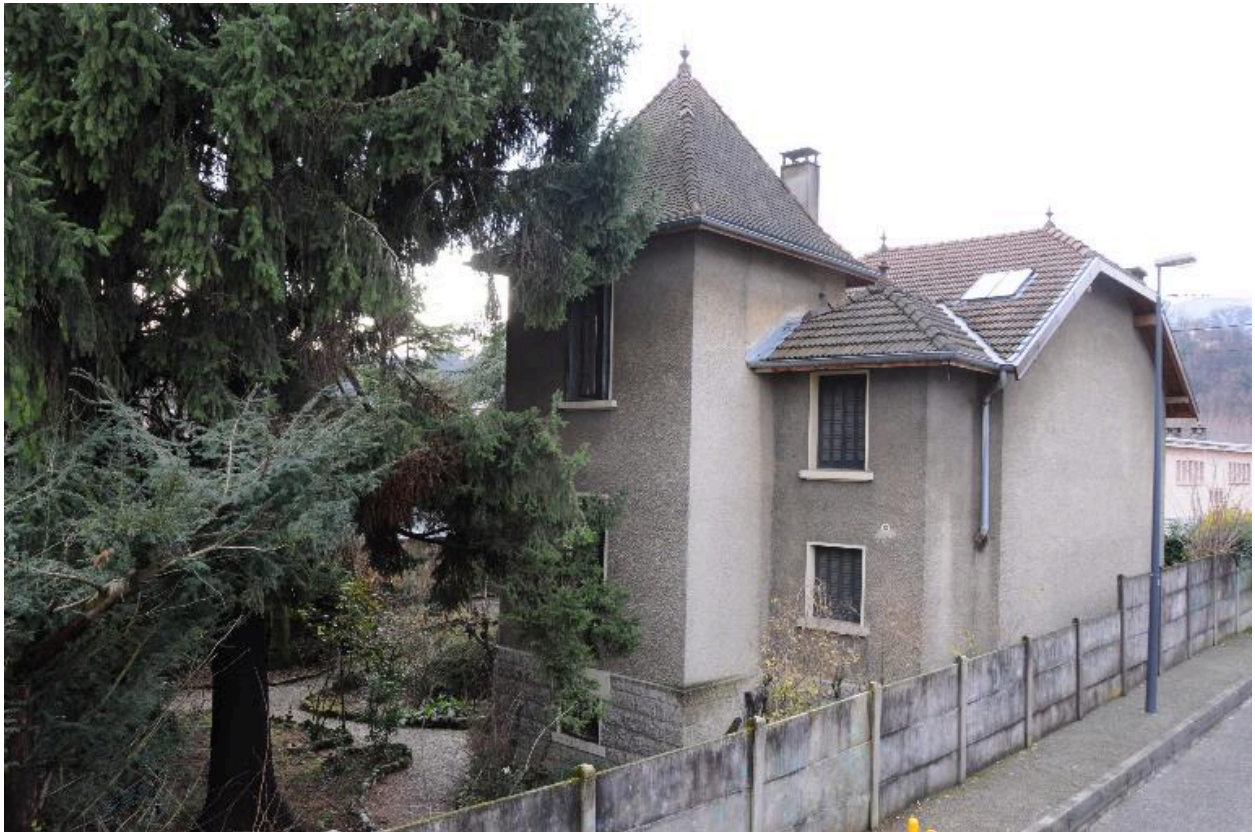
Vue depuis l'arrière
