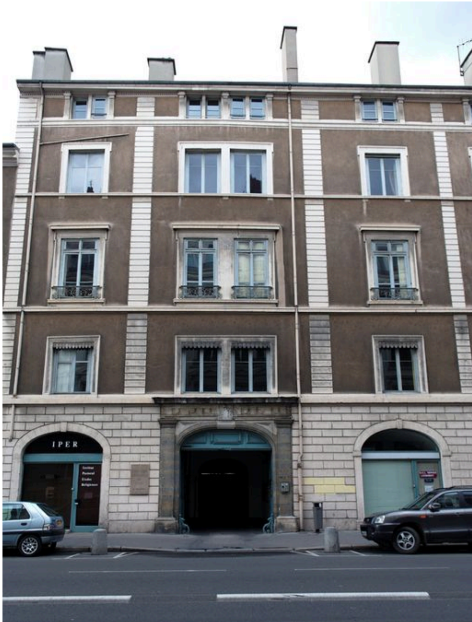
Elévation antérieure, partie orientale
