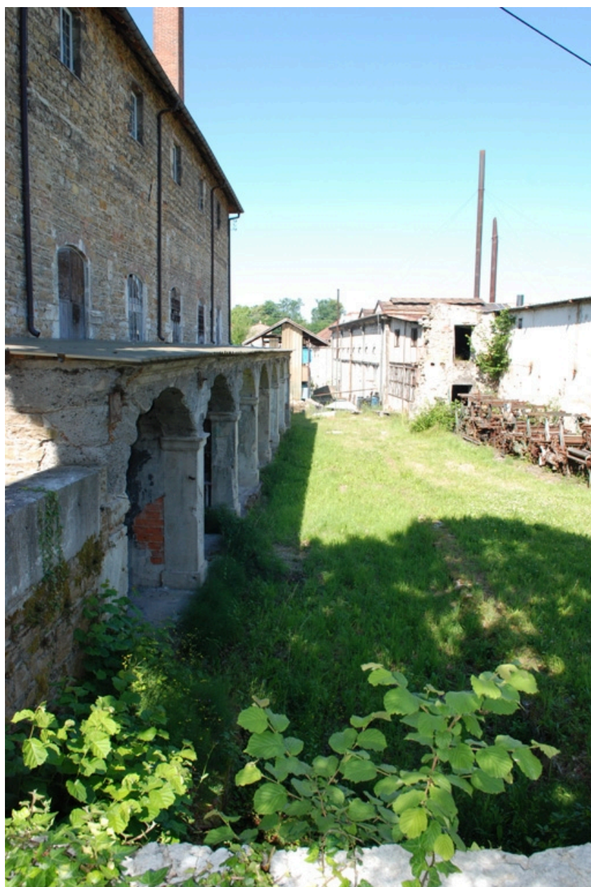
Niches de la façade nord de la forge
