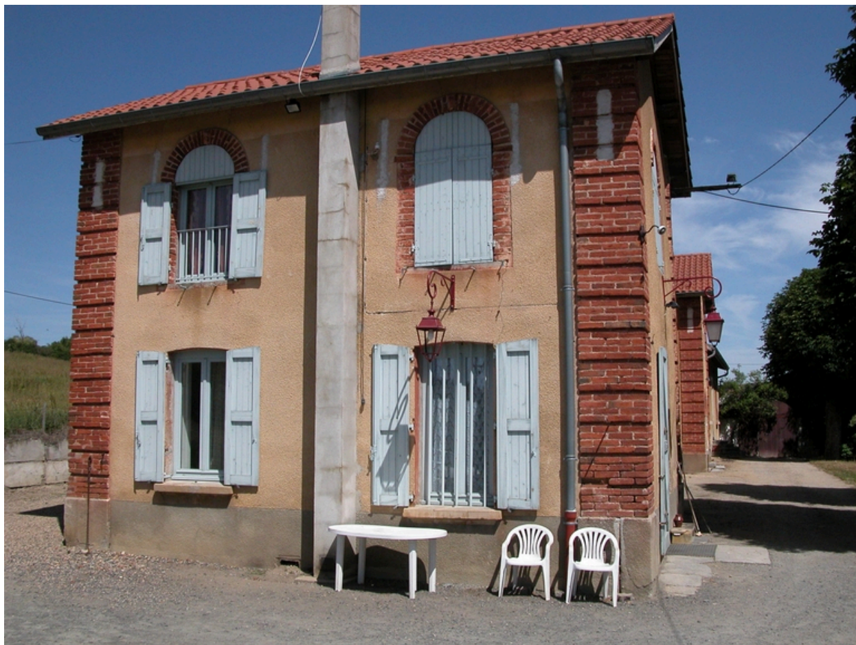
Vue depuis le sud : façade latérale du pavillon sud.
