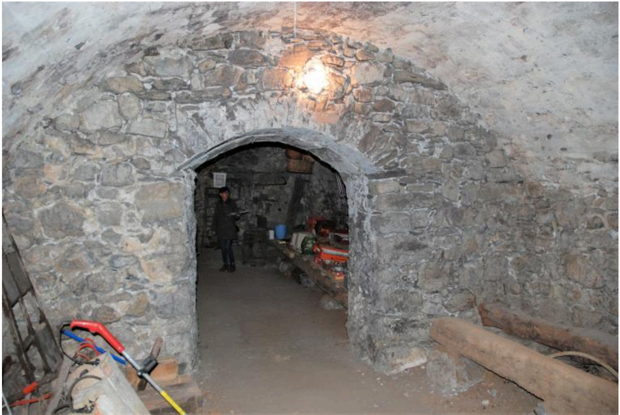
Sous-sol, deuxième cave voûtée, vue d'ensemble vers l'ouest.
