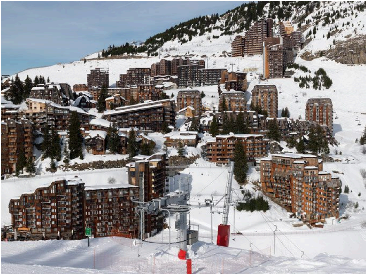
Vue depuis l'ouest : les quartiers des Dromonts et des Crozats
