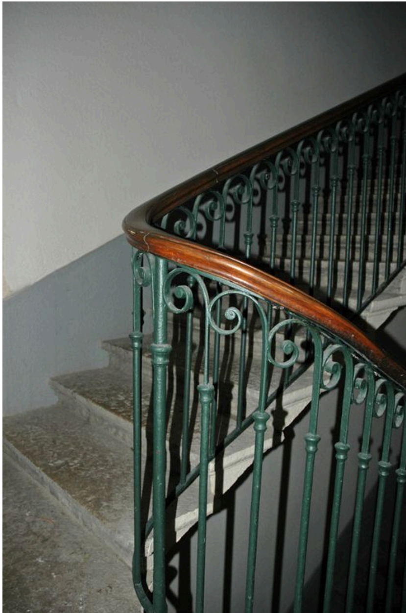
Détail de la rampe de l'escalier
