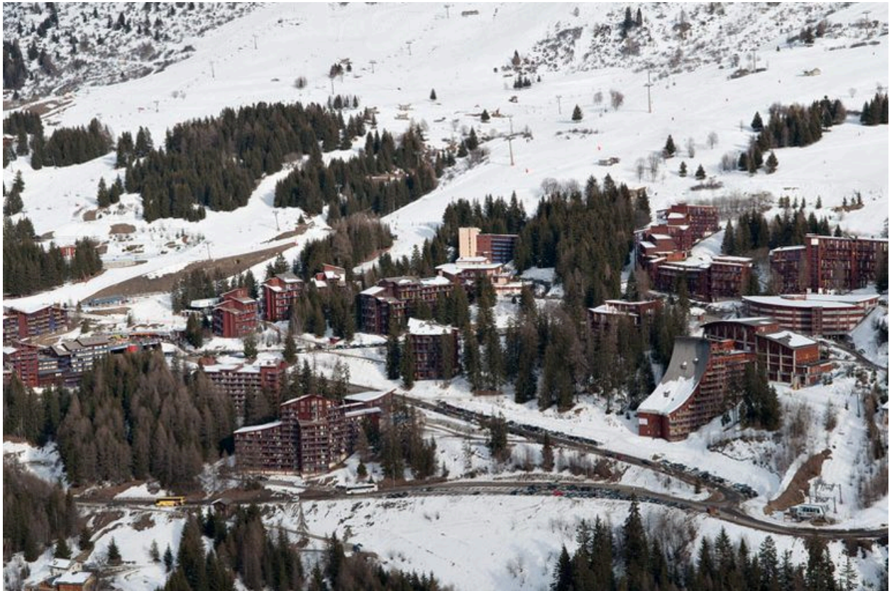
Vue aérienne rapprochée depuis l'ouest. Charmettoger
