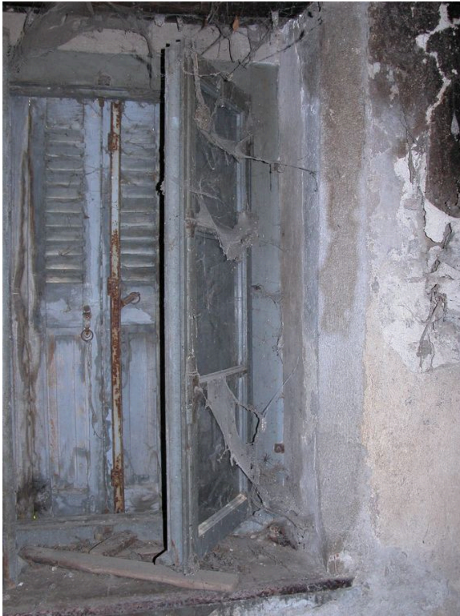
Vue intérieure du cellier : fenêtre ouest (encadrement chanfreiné).
