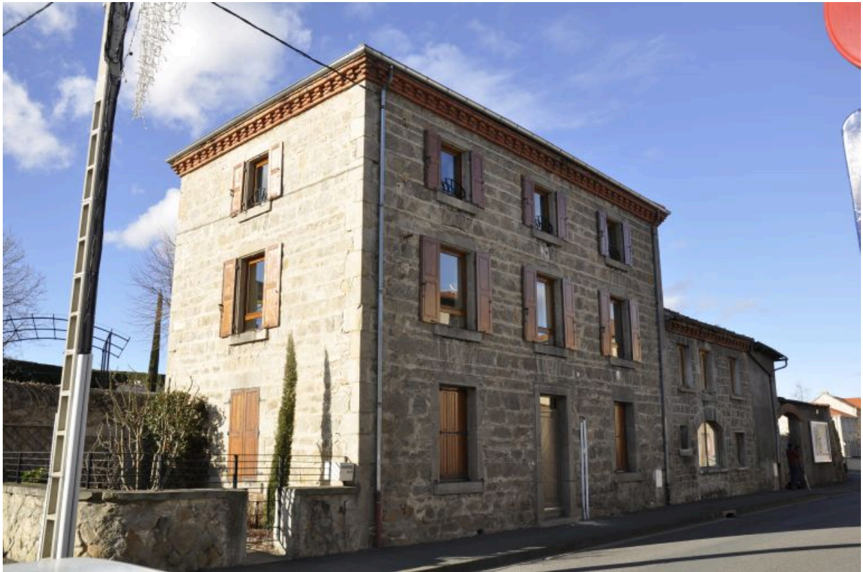
1986 AE 532, 531. 6, 4 rue de Saint-Anthème. Maison avec dépendance dans le prolongement, vue d'ensemble sur rue.
