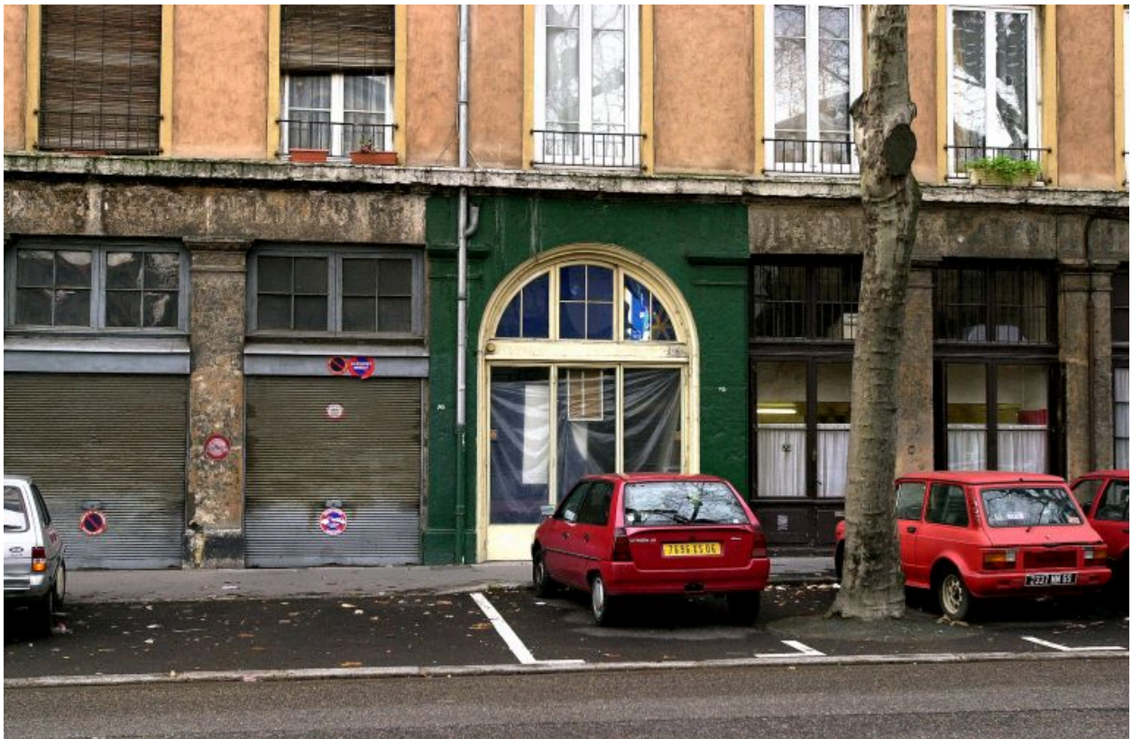
Vue des boutiques au rez-de-chaussée, cours Suchet : les piliers en pierre de taille
