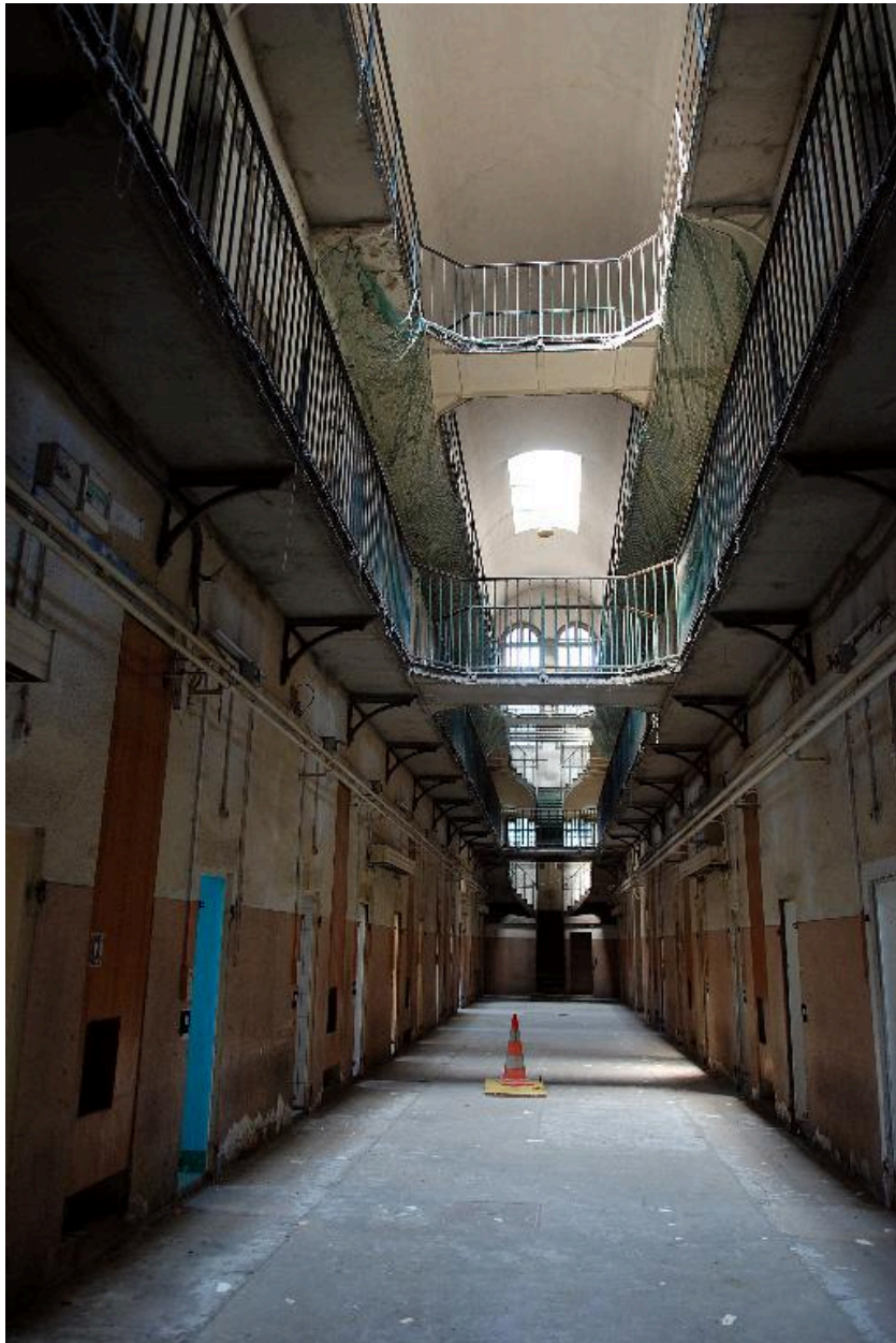
Etat en 2010 : l'aile nord, depuis le rez-de-chaussée
