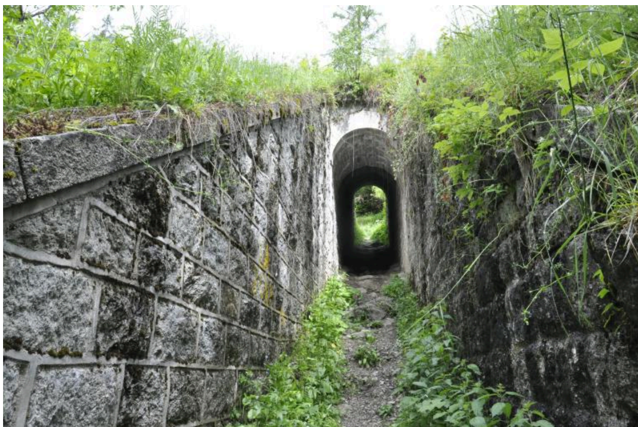
Vue de la face sud-est de l'aqueduc
