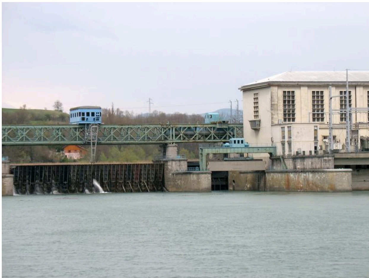
Vue partielle de l'usine-barrage, face aval (sud)
