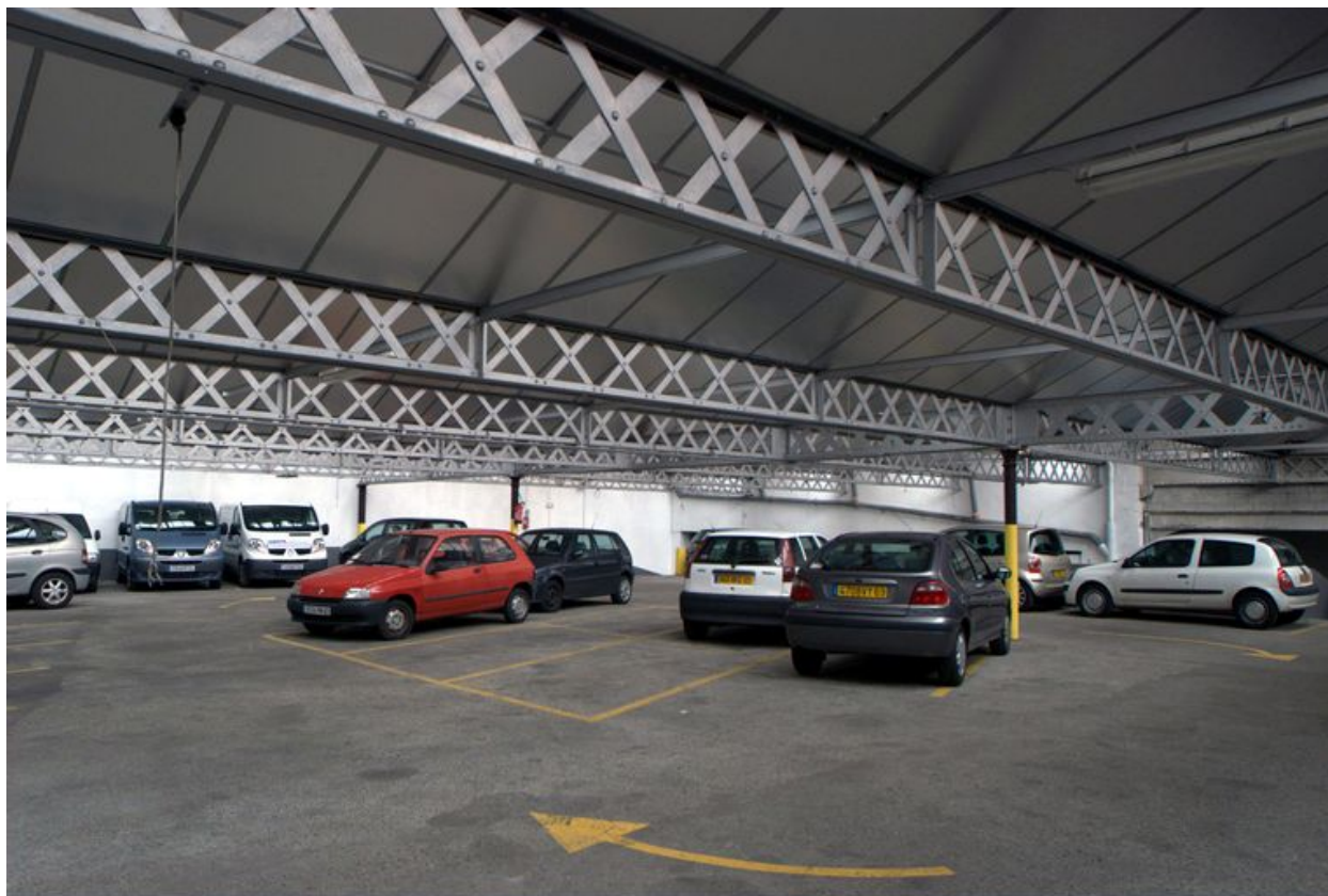
Vue d'ensemble du parc de stationnement
