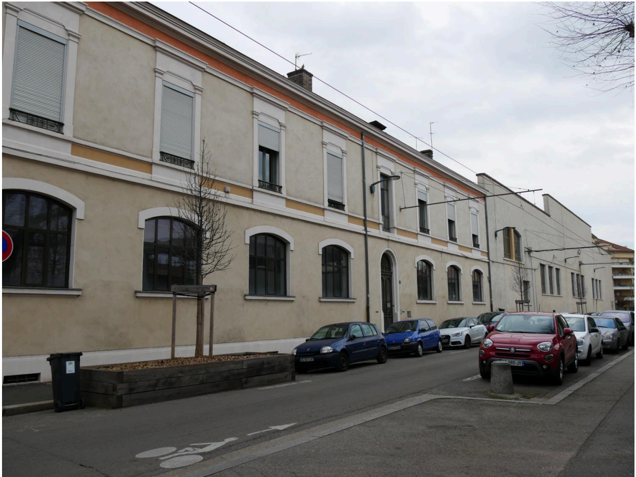
Vue façade rue d'Alsace
