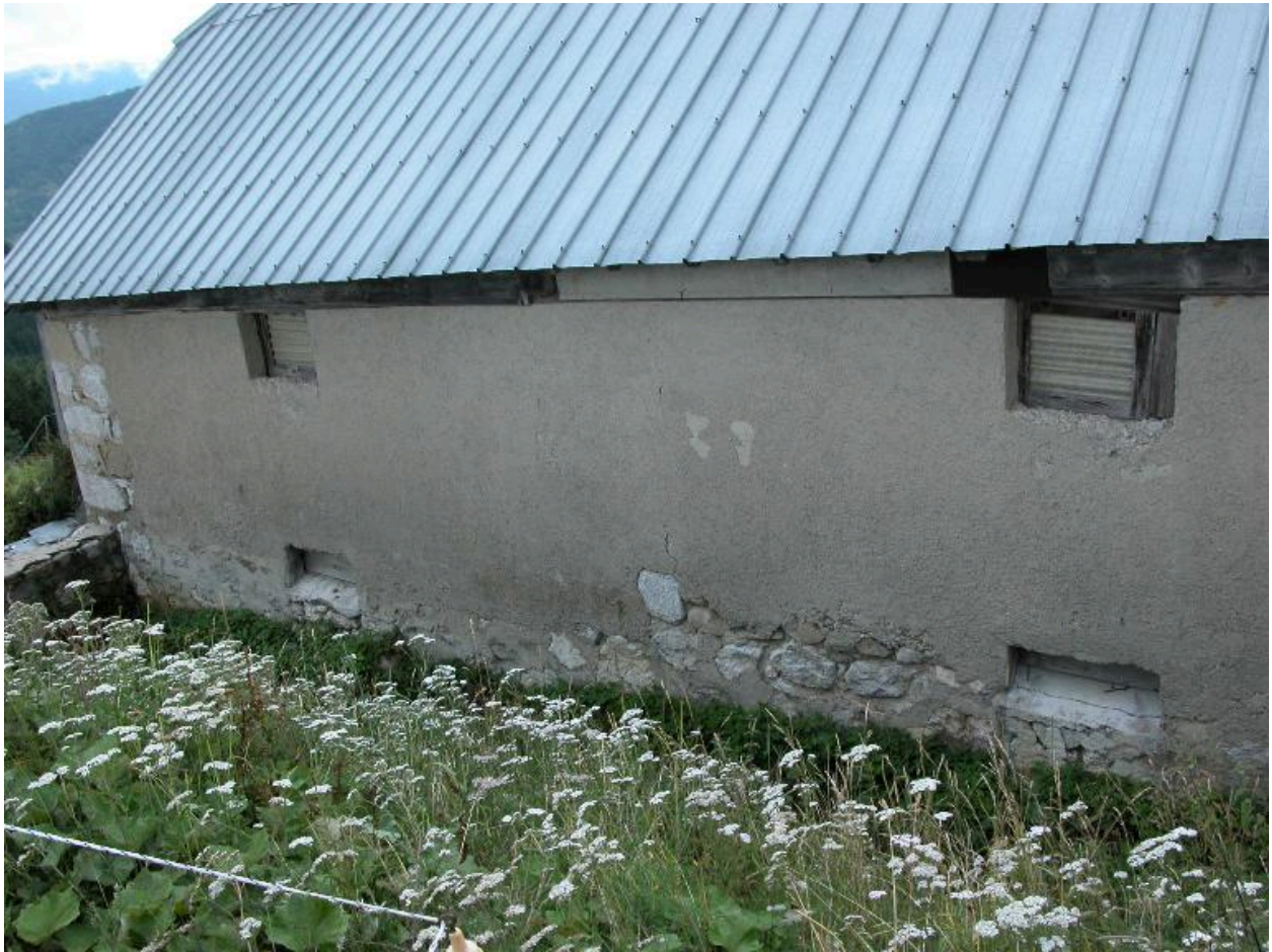
Vue du mur sud de l'étable.
