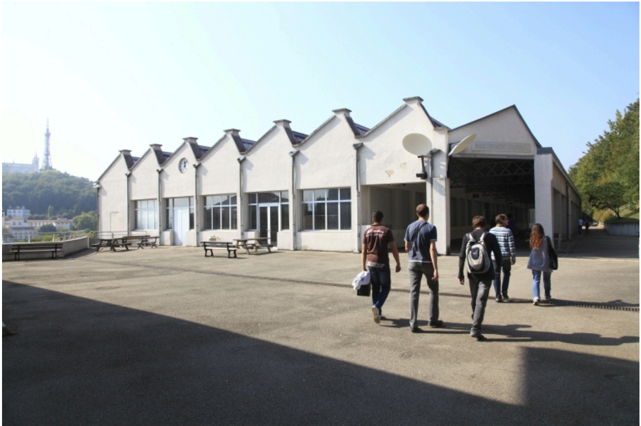
Vue extérieure. Terrasse supérieure et niveau final du bâtiment des ateliers, couverts en sheds.
