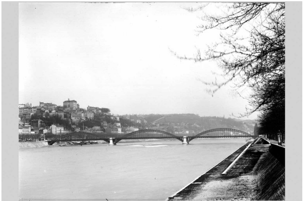
Le pont de la Boucle achevé. Vue d'ensemble depuis le sud. Photogr., [1903] (Arch. mun. Lyon. 15 Ph 1850)
