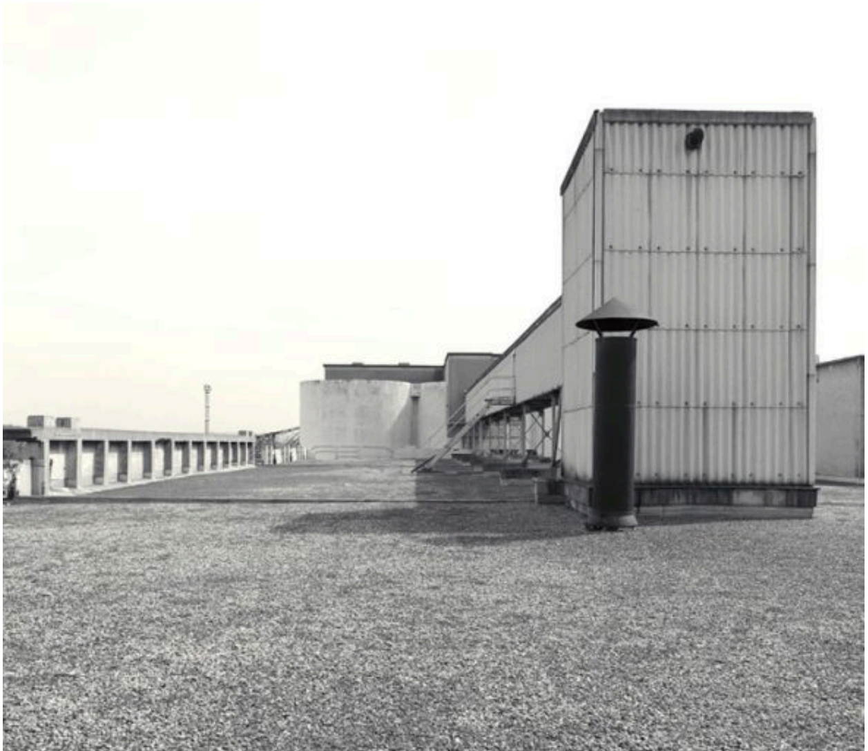
La galerie de liaison aérienne entre les silos et les ateliers depuis le nord-est
