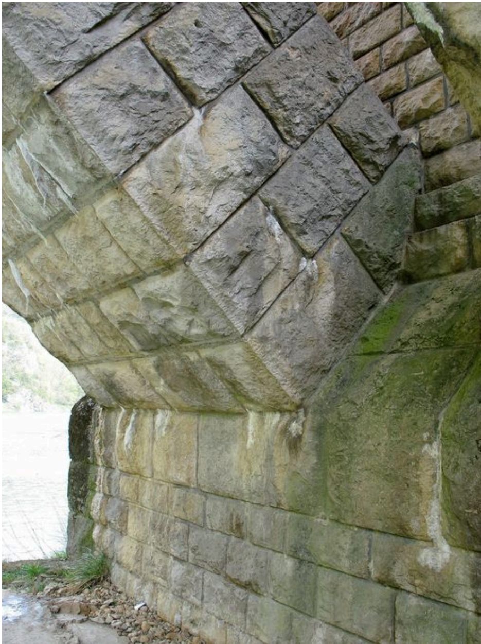
Sous le pont, rive gauche : retombée de l'arche, vue partielle
