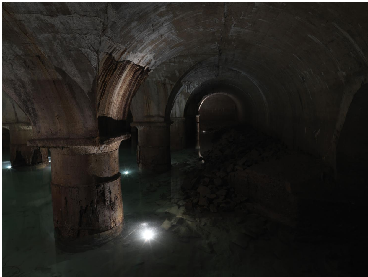
Détail bassins filtrants
