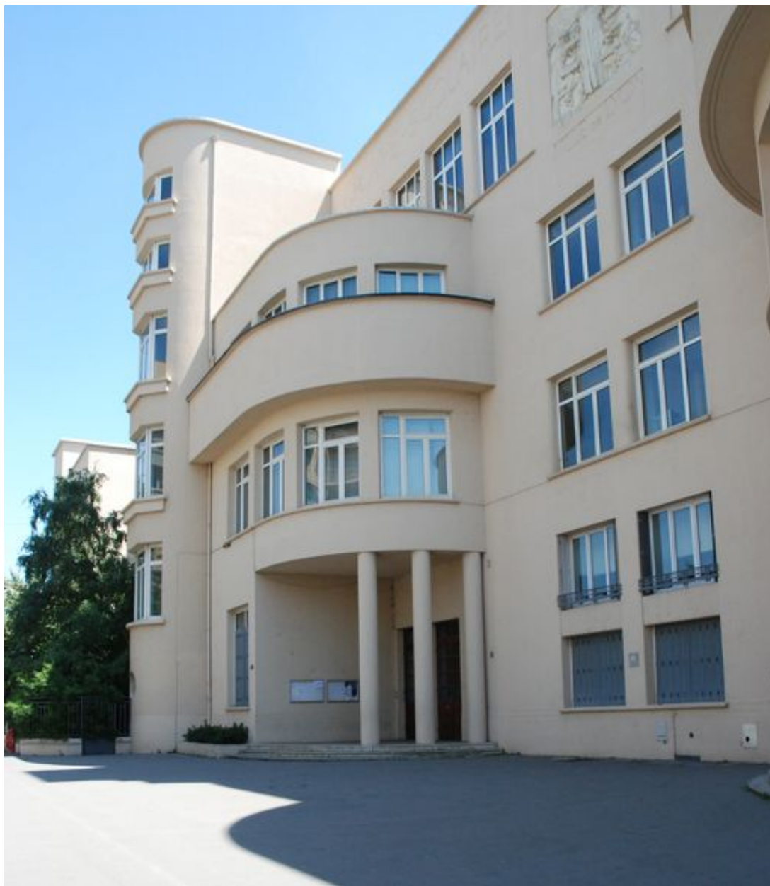
Vue sur l'entrée latérale nord
