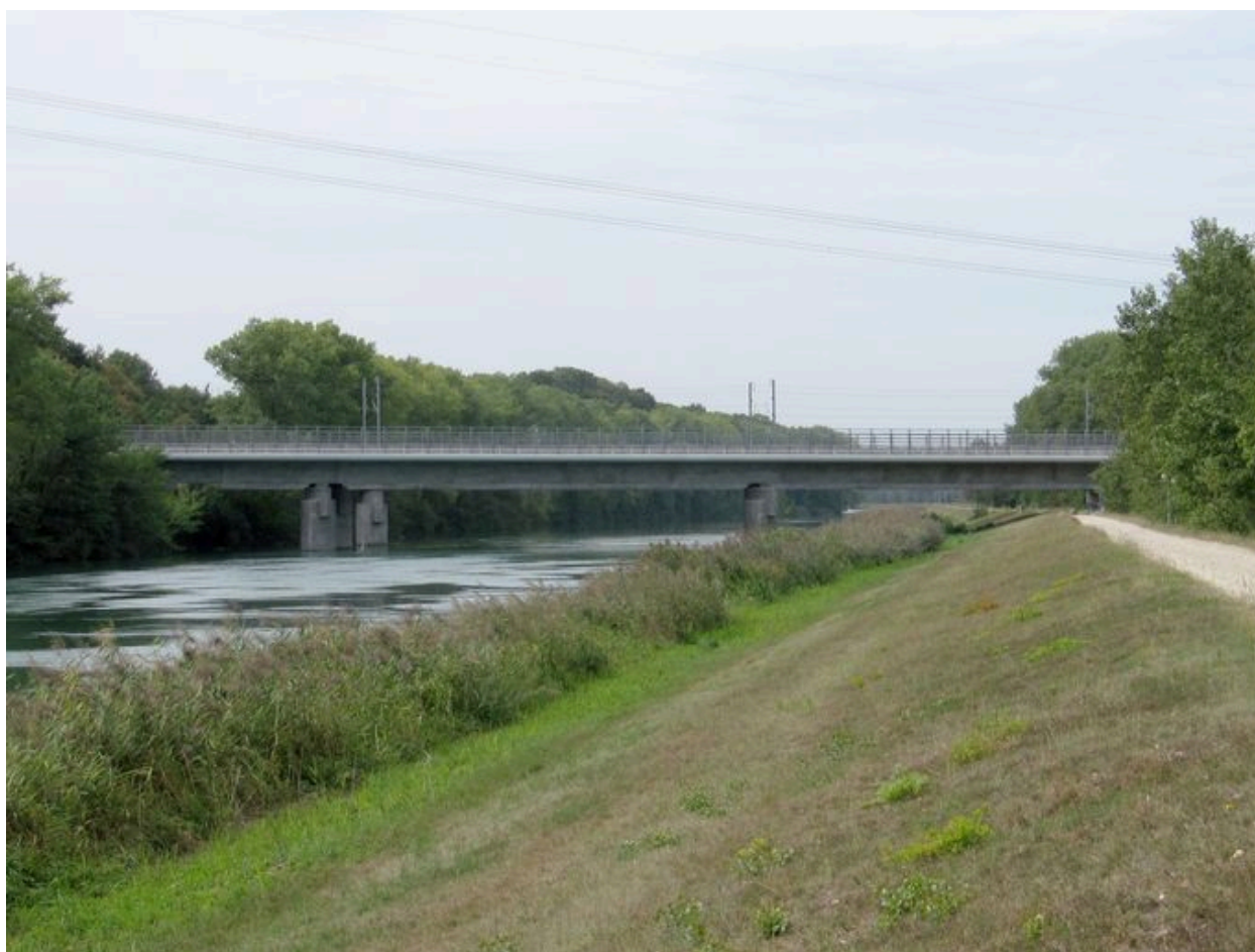
Vue générale de la partie du pont sur le canal de Jonage, face amont (depuis la rive droite)
