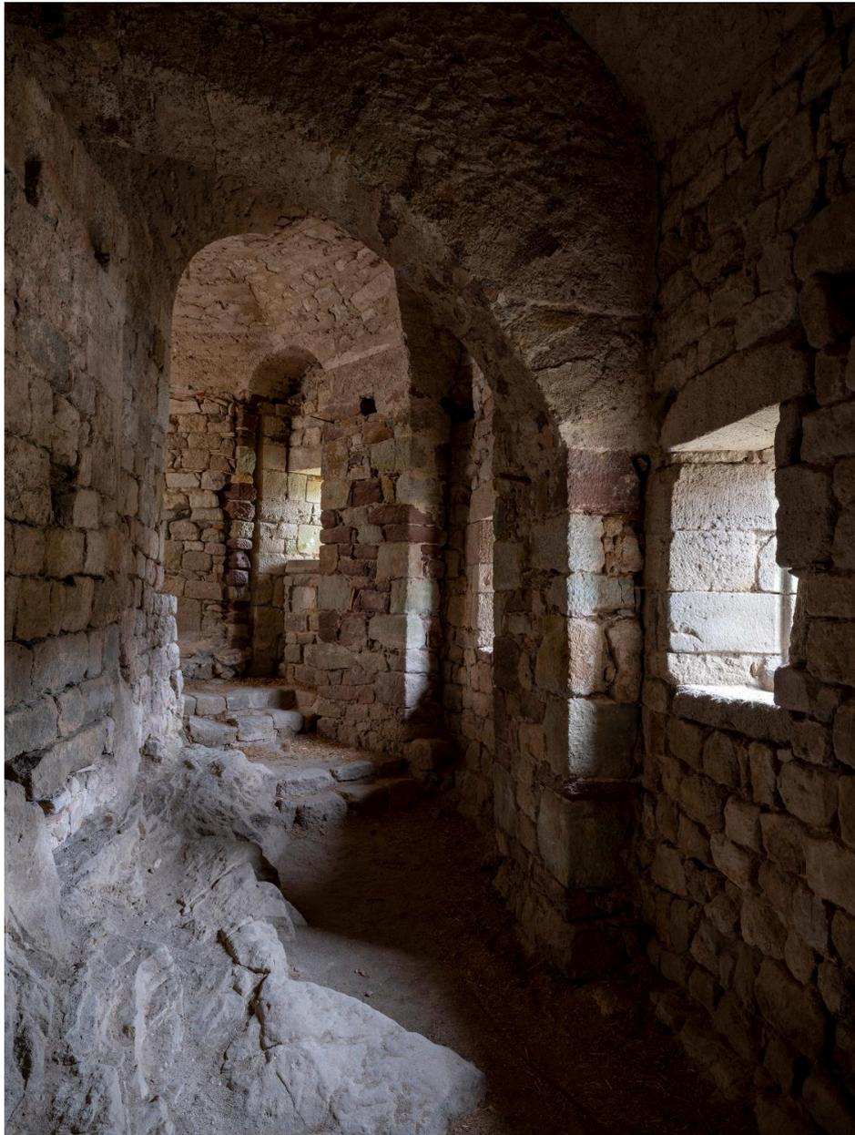
Aile nord, sous-sol : rampe d'accès en partie taillée dans la roche, faisant communiquer la salle d'arme du châtelet et le vestibule de la chapelle
