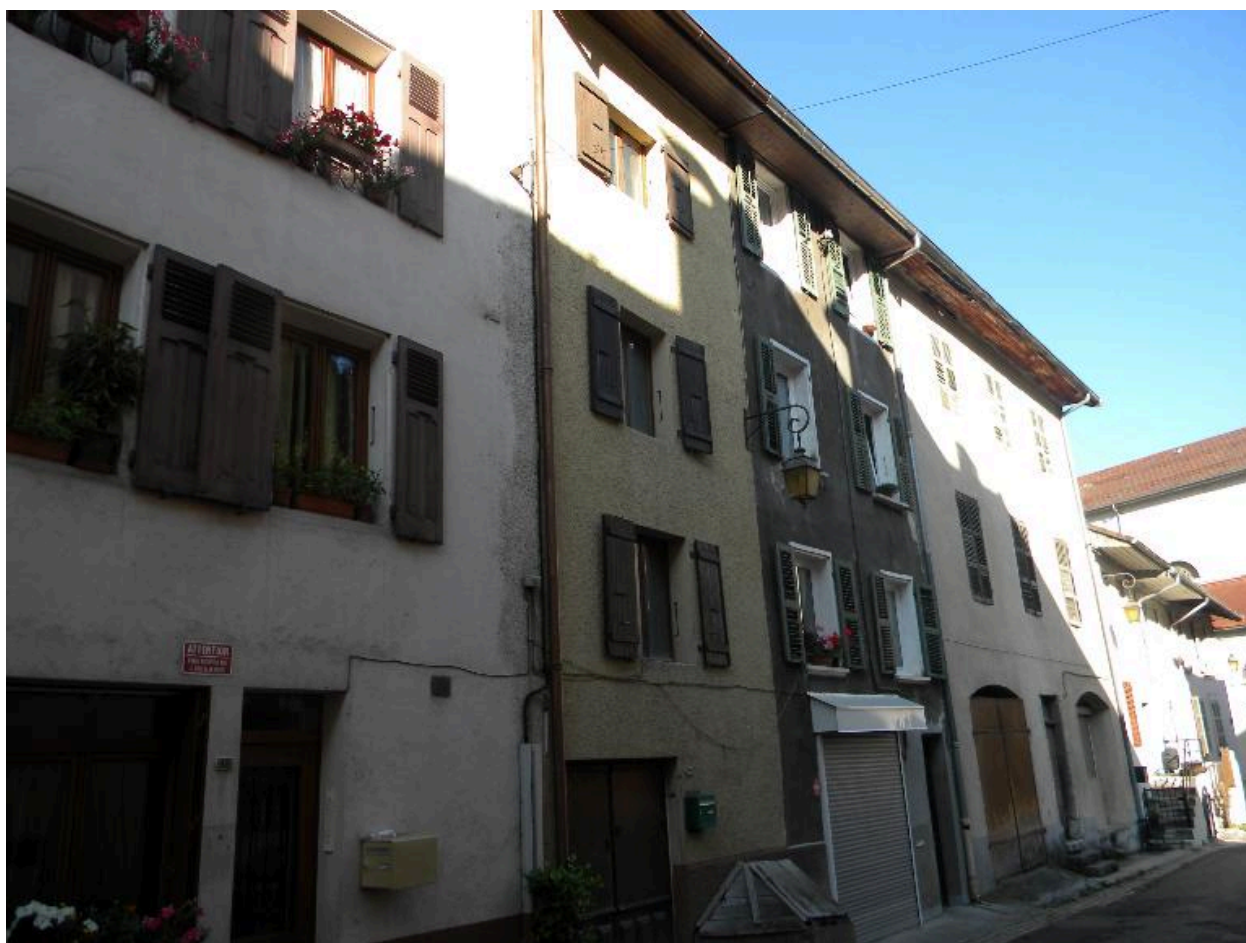
Détail des façades de 4 immeubles rue Nicolas Blanc (2008 D15 2425, 2426, 2428, 2429).
