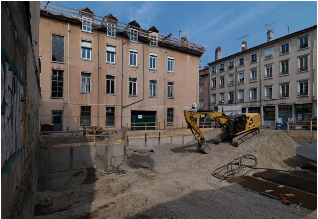
Vue d'ensemble depuis l'est, après démolition des ateliers
