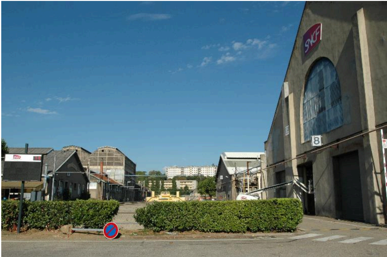
Vue extérieure des ateliers de la Mulatière : à droite chaudronnerie de fer 1882
