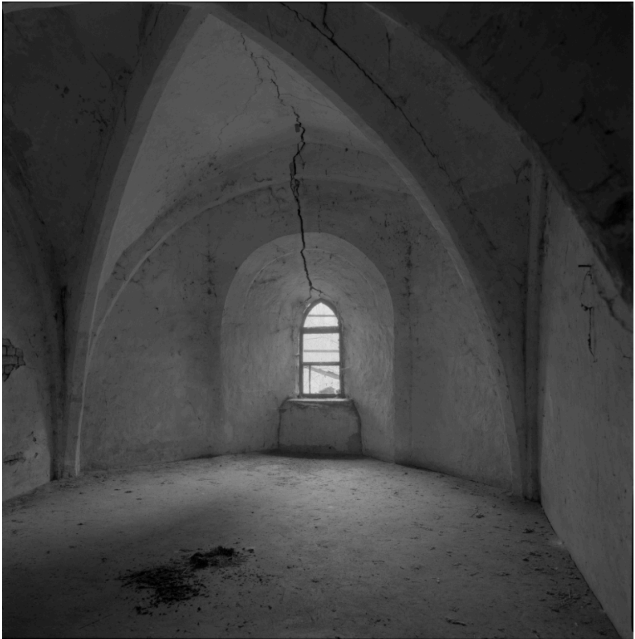
Vue intérieure de l'absidiole sud, en partie haute.
