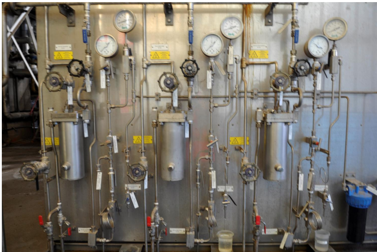
Vue de l'intérieur des ateliers
