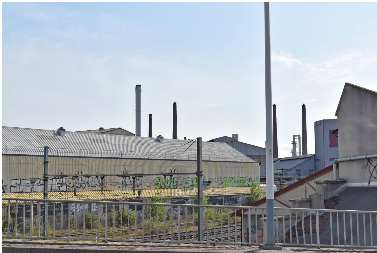
Aciéries de Longwy en 2022 vues depuis l'autopont
