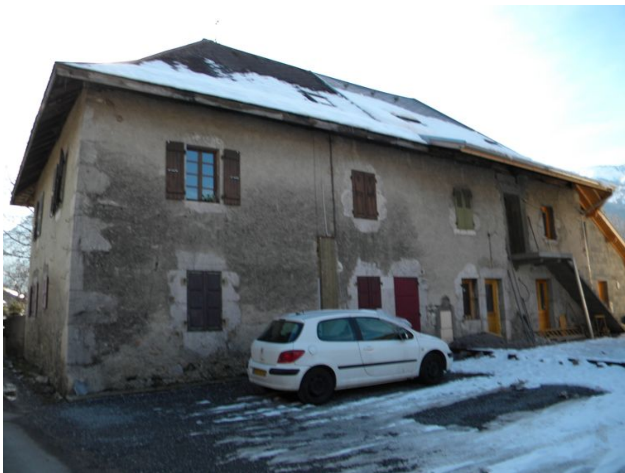
Vue de la façade arrière avec habitation d'une autre ferme accolée.
