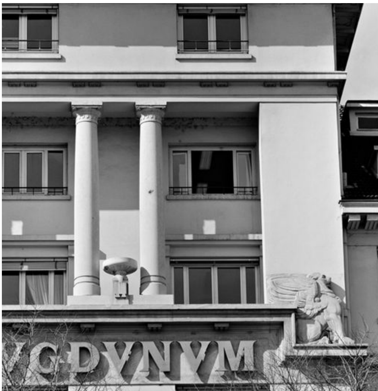
Elévation antérieure : loggia, colonnes et lion ailé
