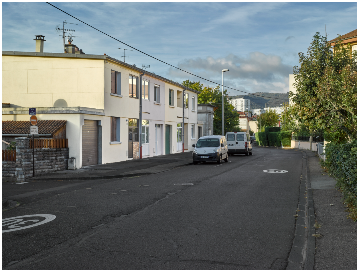
Maisons doubles accolées en bande continue (type Bezance), années 1960-1964 (cité de Lachaux).
